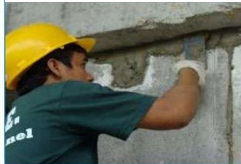
在梁和板上插入 T10 销钉/钢筋
