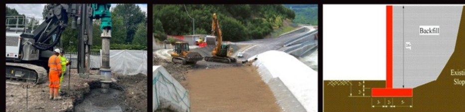
稳定土壤 道路基层 挡土墙回填
